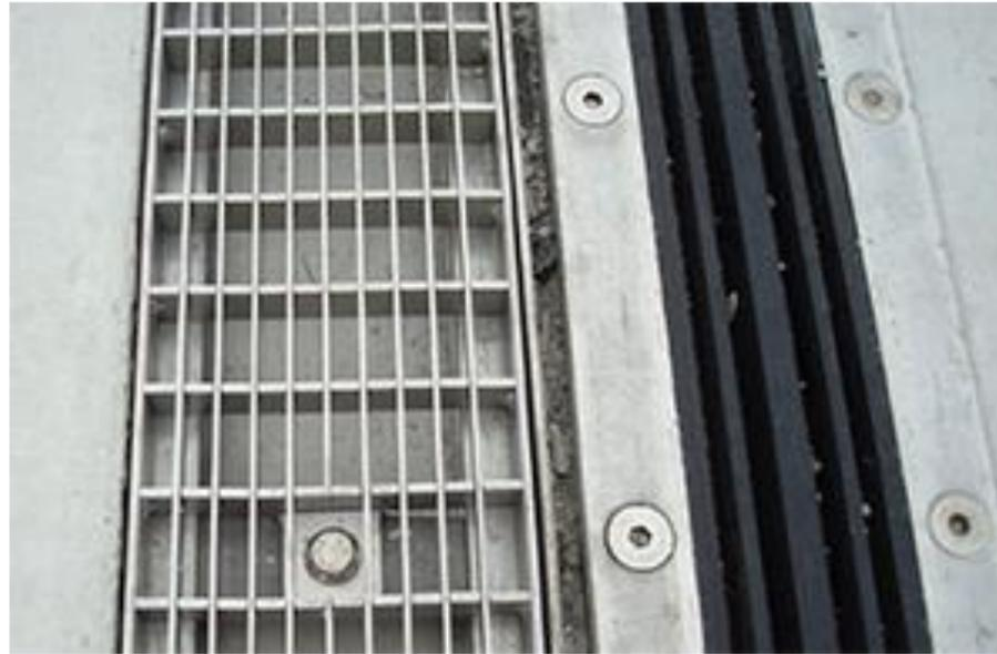
*Fig. 17 Referentiefoto : roostergoot voor verzamelen water met naastliggende voeg (ter hoogte van de brug met de bestaande verharding)*
