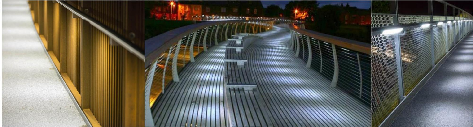
*Fig. 16 Referentiefoto's : geïntegreerde verlichting in leuning*
